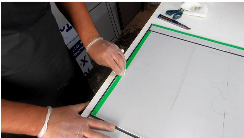
O procedimento de limpeza deve também ser realizado na estrutura base, apenas nos pontos em que receberá contato com a fita.
