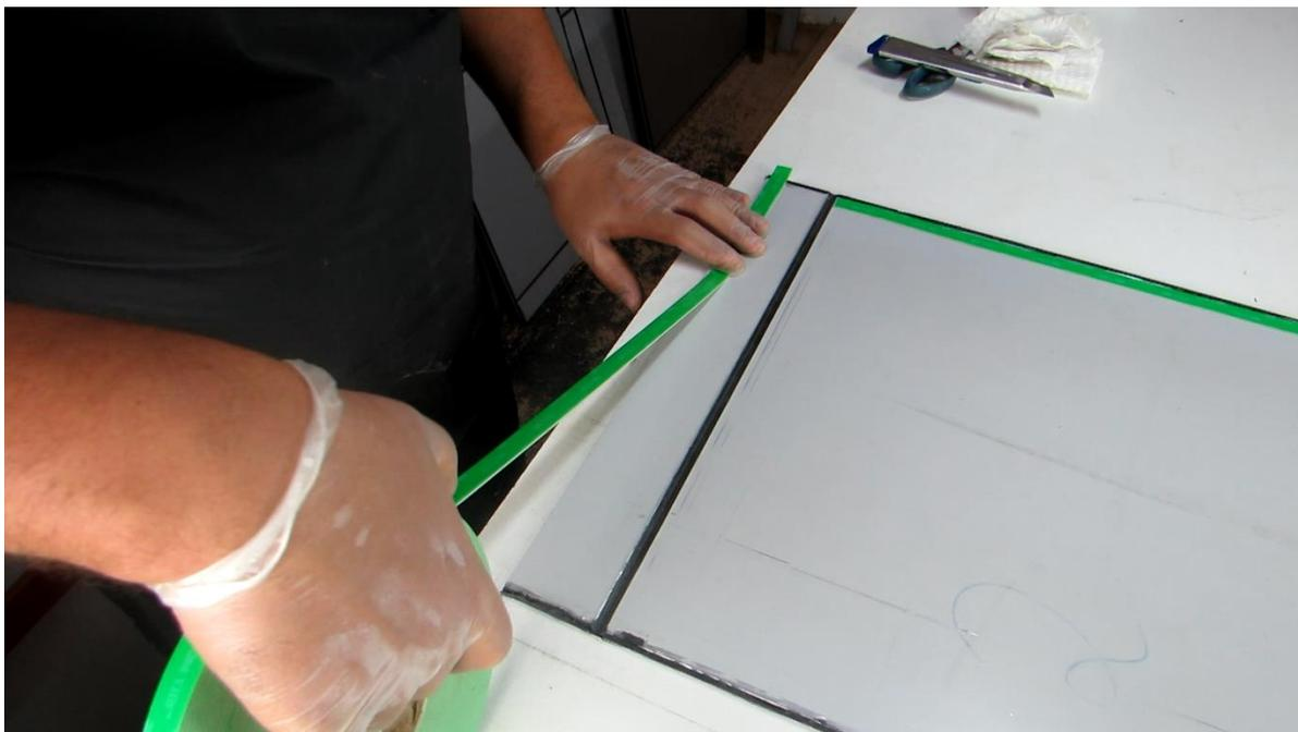
No início da aplicação, caso a mão do operador entre em contato com a fita, este pedaço deve ser inutilizado.
