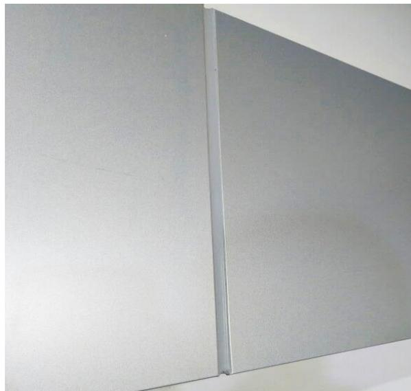
Painéis com junta de dilatação
